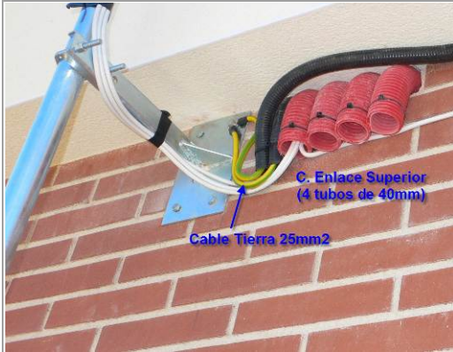
Foto ejemplo C. Enlace Superior y T.T. cable 25mm 2
