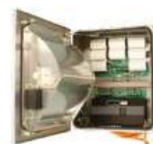
COLOCACIÓN CABLE DE CONEXIÓN
