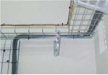
Fig. 1.12. Bandeja perimetral en un RITI.
