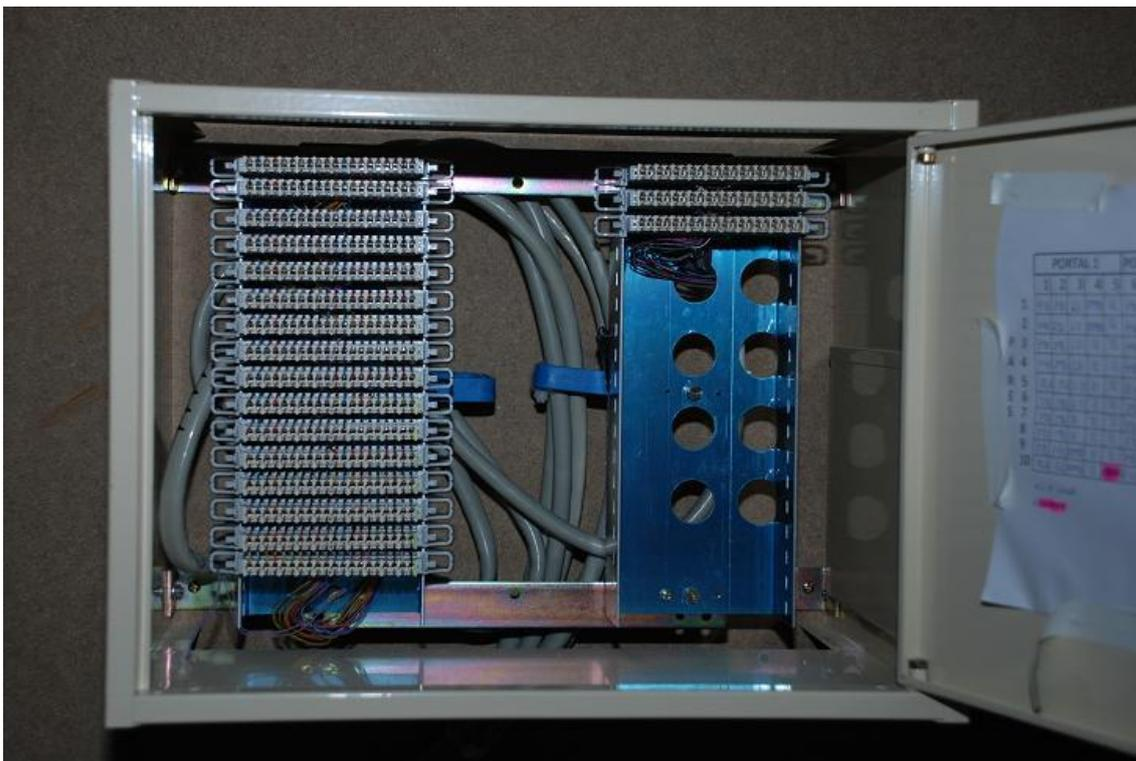
**El registro principal de cable de pares deberá permitir colocar el doble de regletas de entrada (del operador) que de salida (las que van a la red de distribución).**
